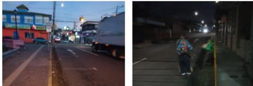
Imágenes 162 - 163. Limpieza de acera, cordón y caño C4-04-027-00.
