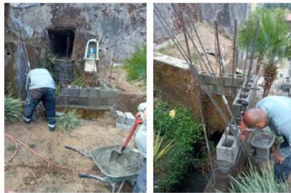
Imágenes 196 - 197. Trabajos en cajas de registro.
