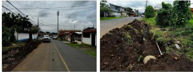
Imágenes 198 - 201. Limpieza de tuberías varias.
