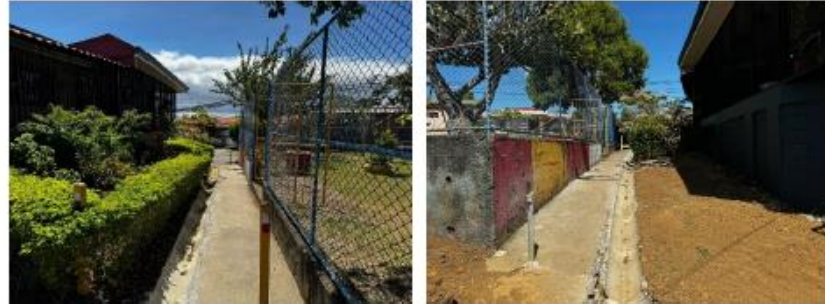
Imágenes 145 - 150. Colocación de paso de alcantarilla C4-04-002-00.
