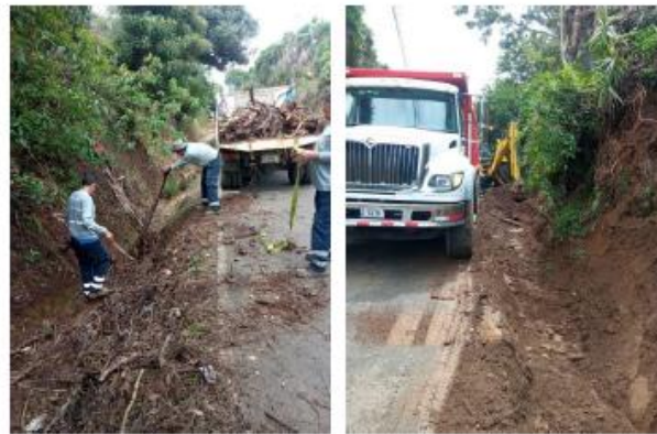
Imágenes 210 - 213. C4-04-011-00 Limpieza de derrumbes.
