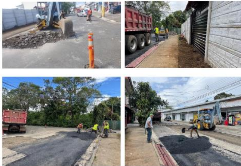
Imágenes 314 - 317. C4-04-065-00 Urbanización Samarcanda.
