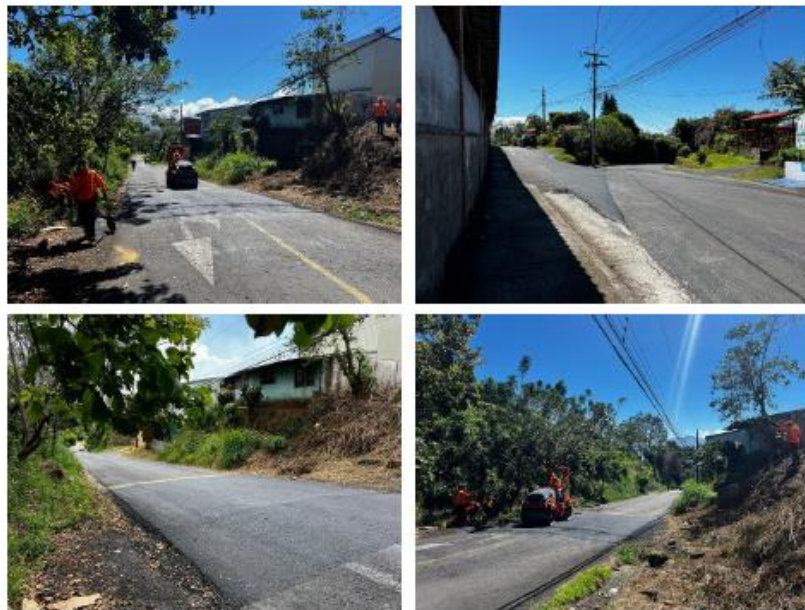
Imágenes 5 - 8. Trabajos en vía C4-04-012-00 Calle Potrerillos.
