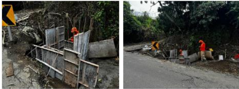
Imágenes 218 - 219. C4-04-012-00 Trabajos sistemas de drenaje.
