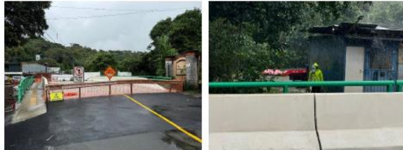
Imágenes 150 - 183. C4-04-023-00 Calle Montero.
