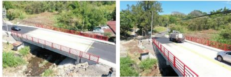
Imágenes 63 - 80. C4-04-043-00 Puente Calle La Claudia.
