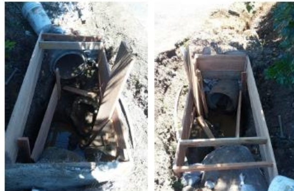
Imágenes 180 - 181. Construcción de caja de registro C4-04-027-00.
