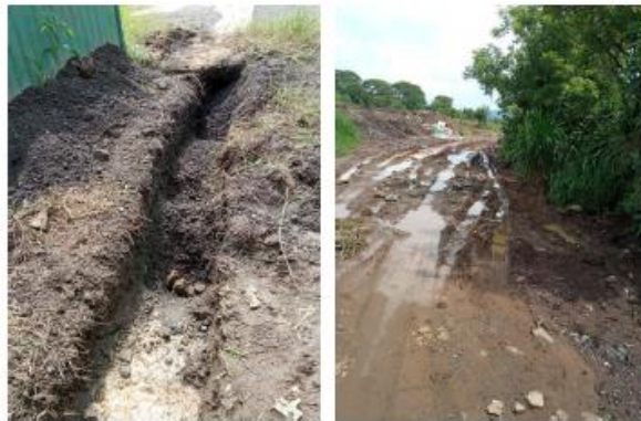
Imágenes 206 - 207. C4-04-009-00 Excavación zanja de retardo.
