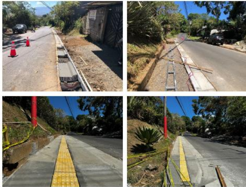
Imágenes 151 - 161. Construcción de acera, cordón y caño C4-04-071-00.
