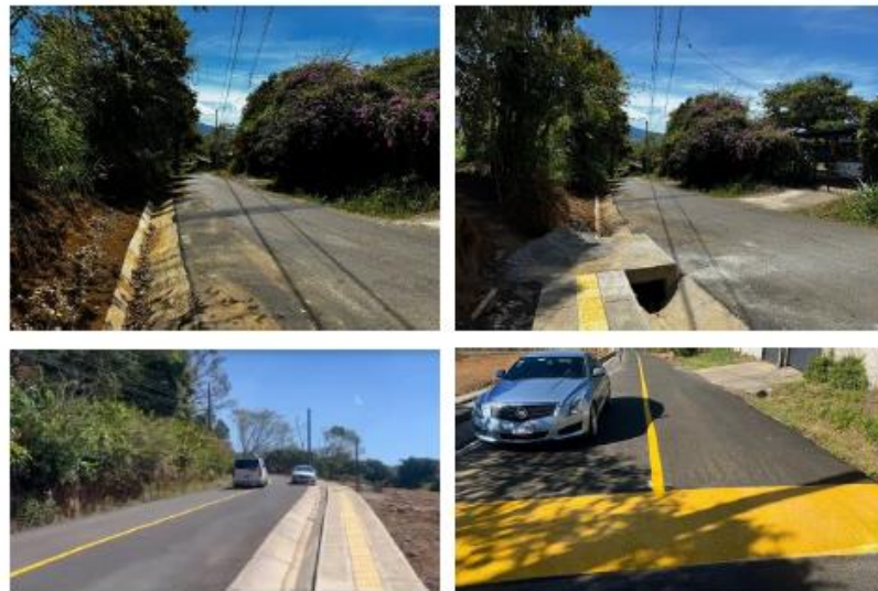
Imágenes 166 - 171. Construcción de acera, cuneta y reductores C4-04-013-00.
