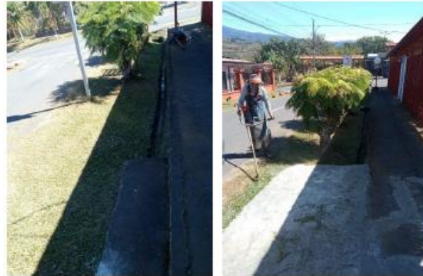
Imágenes 176 - 179. Limpieza de cordón y caño C4-04-027-00.
