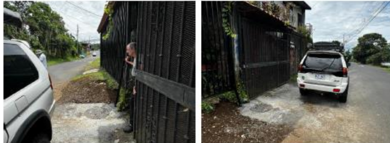
Imágenes 220 - 221. C4-04-027-00 Trabajos sistemas de drenaje.
