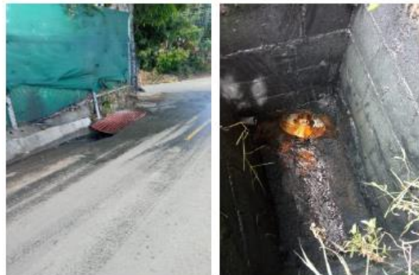
Imágenes 194 - 195. Limpieza de tuberías varias.
