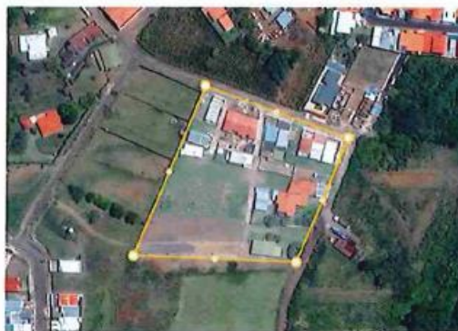
Imagen 10. Área por intervenir, etapa 1.
