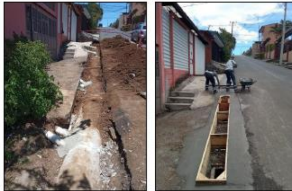
Imágenes 293 – 294. Reparación de tubería, cordón y caño C4-04-027-00.
