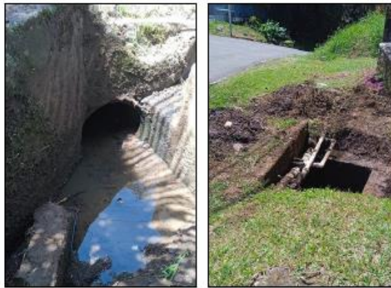
Imágenes 280 – 281. Limpieza de caja de registro y cabezal en calle Cuadrantes Betania C4-04-071-00.
