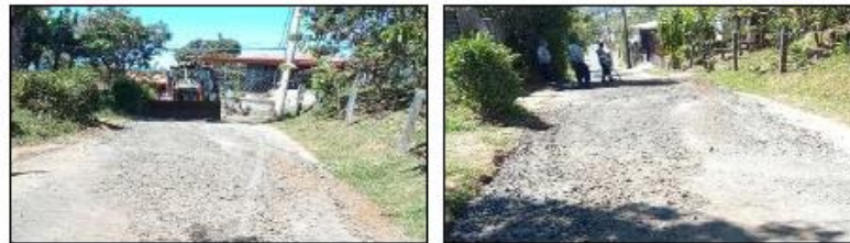
Imágenes 244 – 245. Trabajos en vía C4-04-128-00 Calle Campos.
