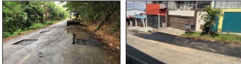
Imágenes 62 - 69. C4-04-025-00 Calle Guachipelines trabajos.
