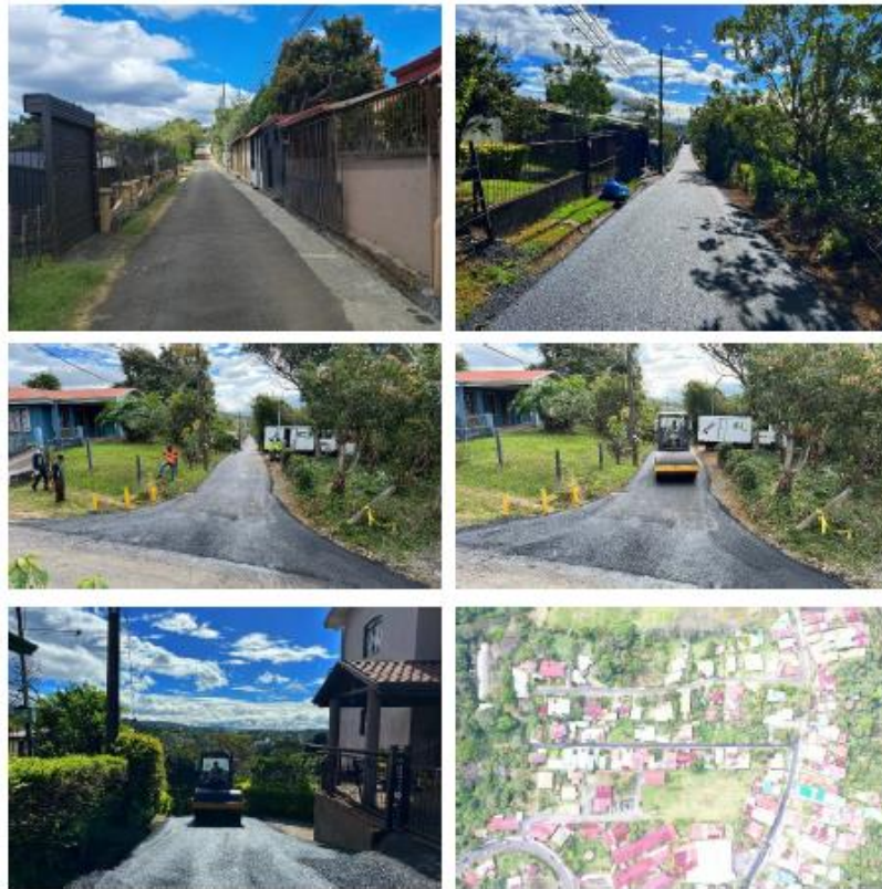
Imágenes 9 – 14. Trabajos en vía C4-04-128-00 Calle Campos.
