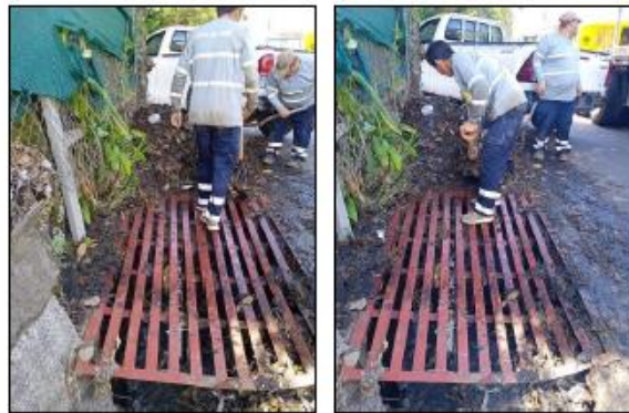
Imágenes 276 – 277. Limpieza de alcantarilla en calle la Claudia C4-04-043-00.
