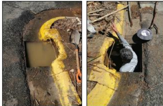
Imágenes 278 – 279. Limpieza de alcantarilla y caja de registro en calle Potrerillos C4-04-012-00.
