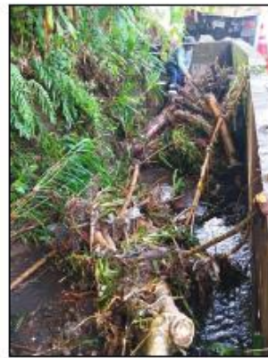
Imágenes 319 – 320. Limpieza de paso de alcantarillo, Calle Rincón C4-04-002-00
