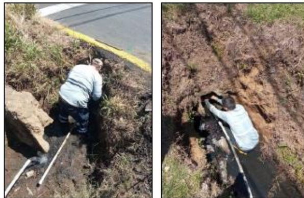
Imágenes 295 – 296. Limpieza de alcantarilla y caja de registro en calle Potrerillos C4-04-012-00.
