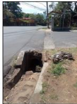
Imagen 288. Limpieza caja de registro C4-04-001-00.
