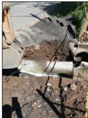
Imágenes 321 - 326. Construcción de alcantarillado, Calle Cajón C4-04-021-00.
