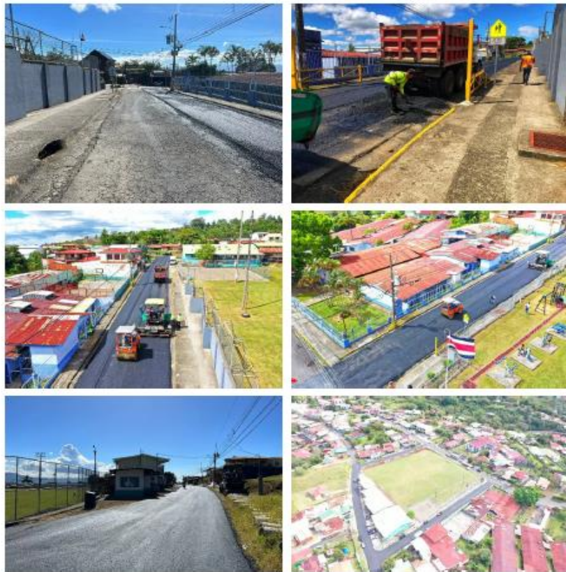
Imágenes 2 – 7. Trabajos en vía C4-04-031-00 Calle Cuadrantes el Roble.
