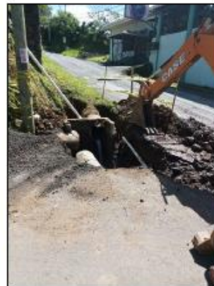
Imágenes 321 - 326. Construcción de alcantarillado, Calle Cajón C4-04-021-00.
