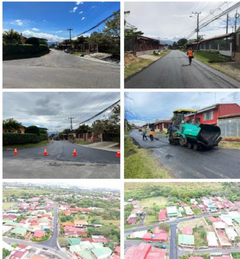
Imágenes 30 – 35. Trabajos en vía C4-04-098-00 Calle Cuadrante San Juan.
