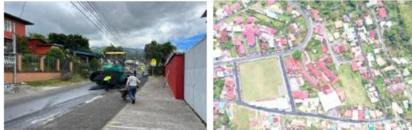
Imágenes 16 – 21. Trabajos en vía C4-04-019-00 Calle Bajo los Cachos.
