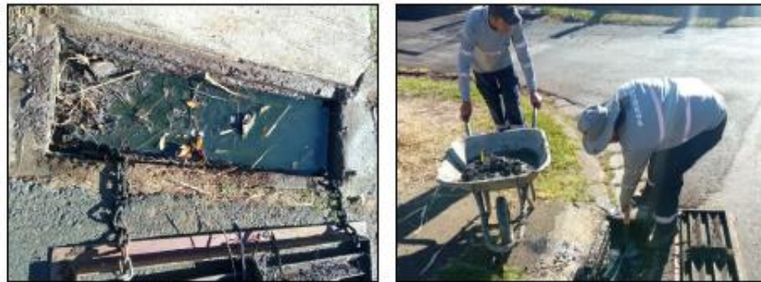
Imágenes 272 – 273. Trabajos en calle Urb. Samarcanda.
