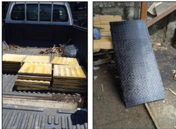
Imágenes 274 – 275. Trabajos mejora de acceso en calle Cuadrantes Sta. Bárbara C4-04-022-00.
