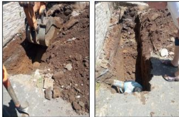
Imágenes 291 – 292. Trabajos mejora en tubería calle el Cerro C4-04-011-00.
