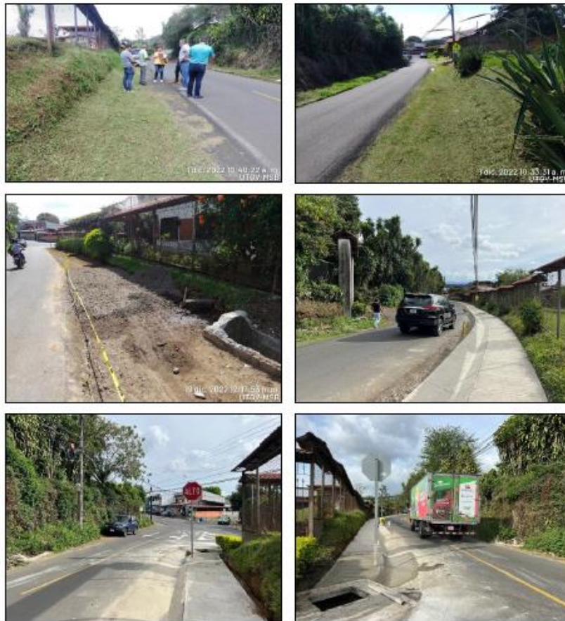
Imágenes 238 – 243. Trabajos en vía C4-04-024-00 Calle Quizarrá.
