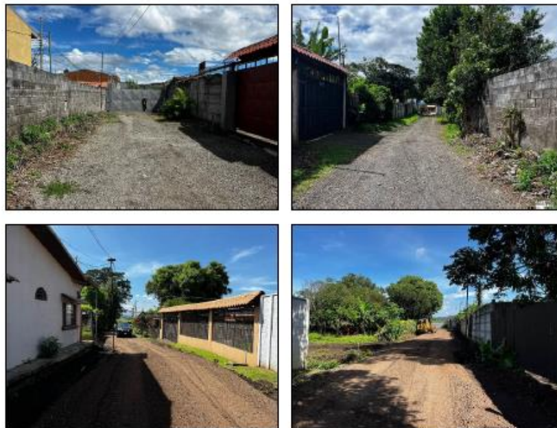
Imágenes 152 - 155. C4-04-031-00 Calle Picado trabajos.
