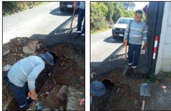
Imágenes 299 - 300. Limpieza de vía Calle Derrumbe C4-04-025-00.
