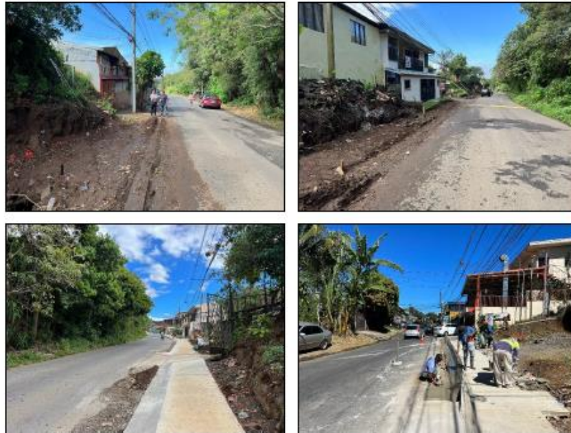
Imágenes 234 – 237. Trabajos en vía C4-04-043-00 Calle la Claudia.
