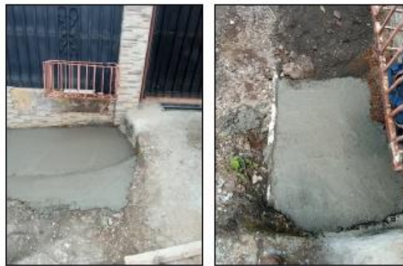
Imágenes 305 - 306. Mantenimiento de vía Calle el Cerro C4-04-011-00.
