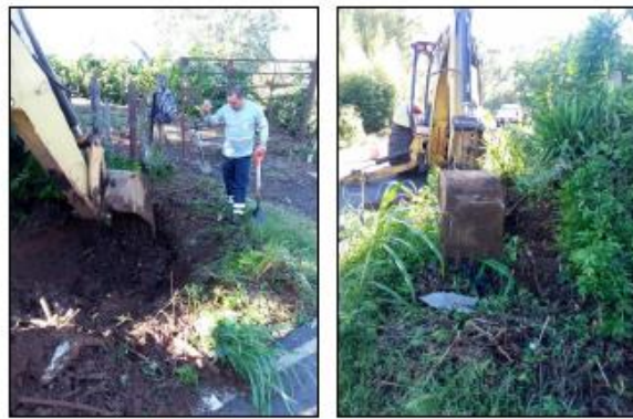
Imágenes 303 - 304. Limpieza de vía Calle Potrerillos C4-04-012-00.
