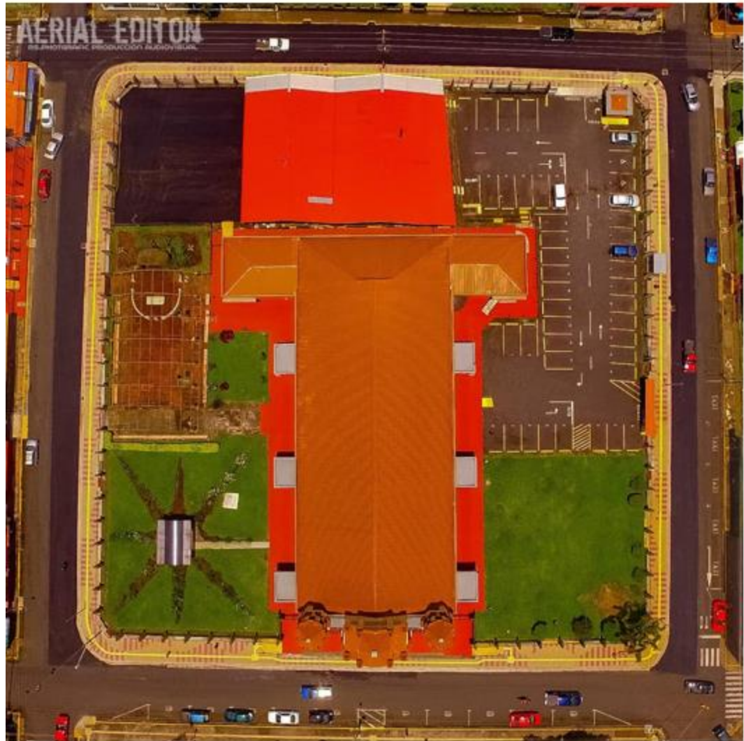
Figura 50. Aceras en el centro de Santa Bárbara. Fuente: Aerial Edition, Ricardo Salas.
