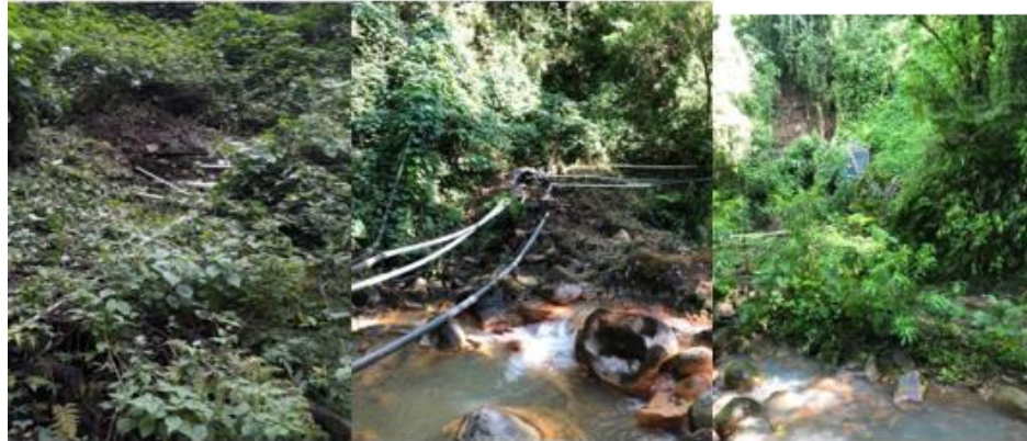
Figura 70. Trabajos por hacer. Fuente: Acueducto Municipal.
