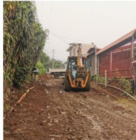
Figura 56. Trabajos en caminos. Fuente: Municipalidad de Santa Bárbara
