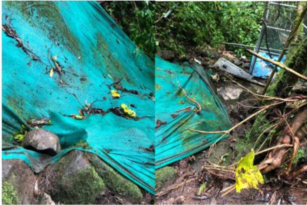
Figura 71. Trabajos por hacer en nacimiento. Fuente: Acueducto Municipal.
