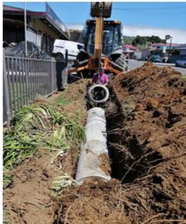
Figura 55. Trabajos de alcantarillado. Fuente: Municipalidad de Santa Bárbara
