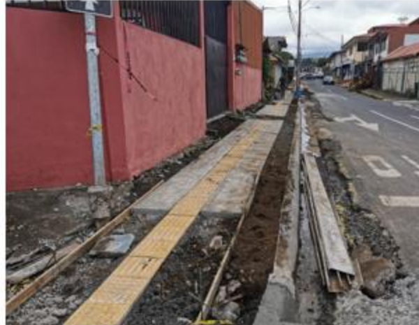
Figura 58. Acera en Santa Bárbara. Fuente: Municipalidad de Santa Bárbara.
