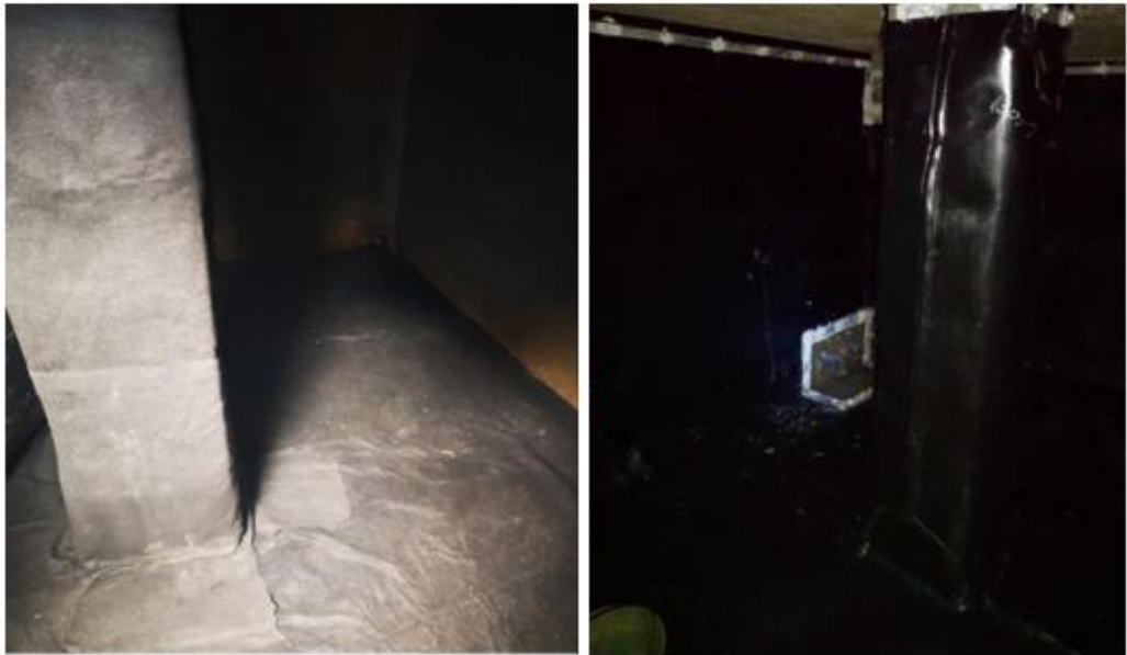
Figura 82. Impermeabilización. Fuente: Acueducto Municipal.
