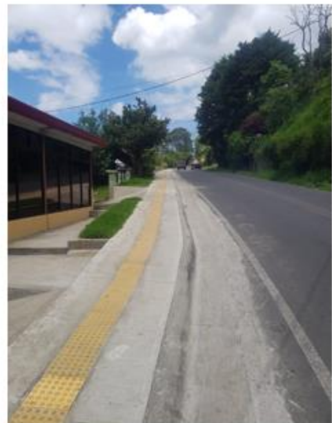
Figura 59. Acera en San Bosco. Fuente: Municipalidad de Santa Bárbara
