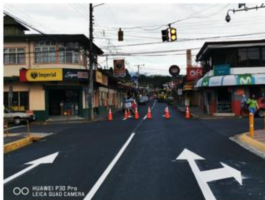
Figura 63. Cambio de vías en Santa Bárbara. Fuente: Municipalidad de Santa Bárbara.
