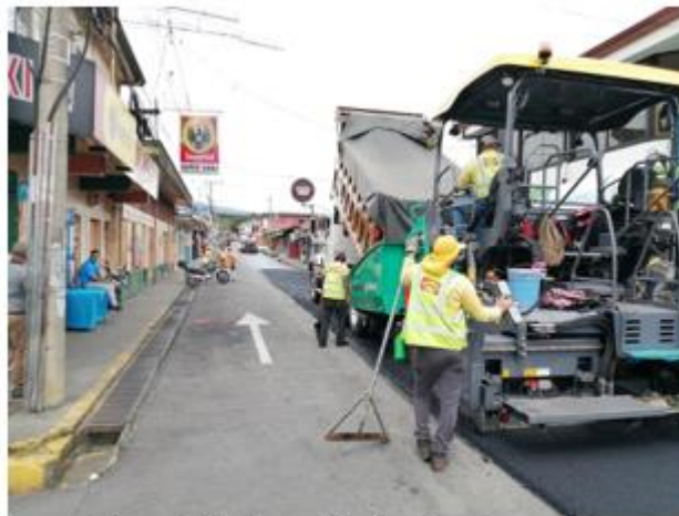
Figura 67. Rutas Nacionales intervenidas. Fuente: Municipalidad de Santa Bárbara.
