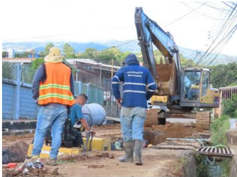
Figura 68. Rutas Nacionales intervenidas. Fuente: Municipalidad de Santa Bárbara.
