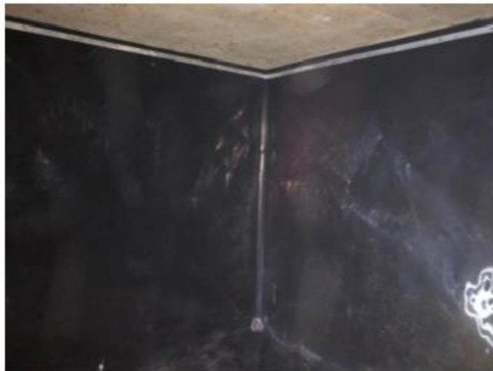
Figura 80. Impermeabilización. Fuente: Acueducto Municipal.
