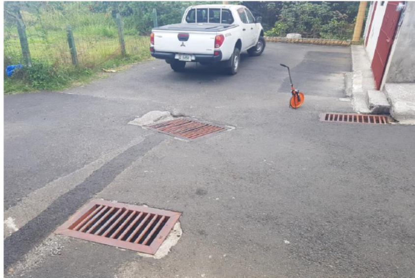
"Imagen #5 – Desfogue y tragantes de rejilla Calle Esparrago"
