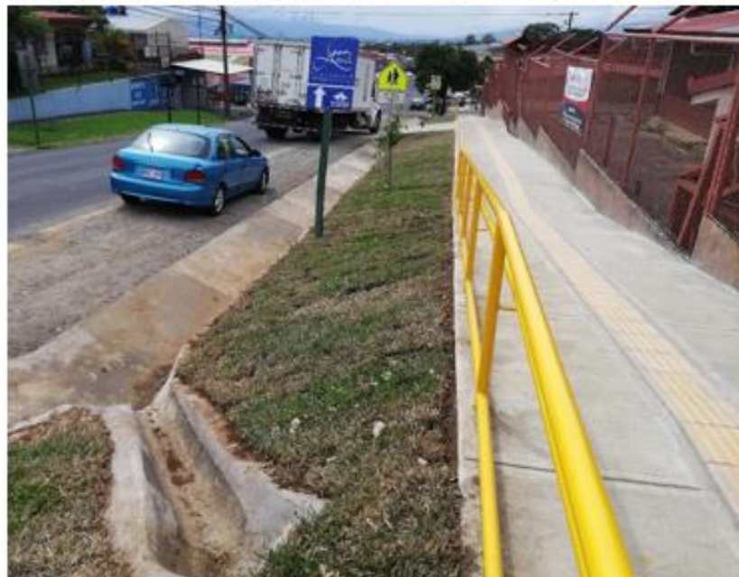
Construcción aceras costado sur Escuela Juan Mora Fernández
