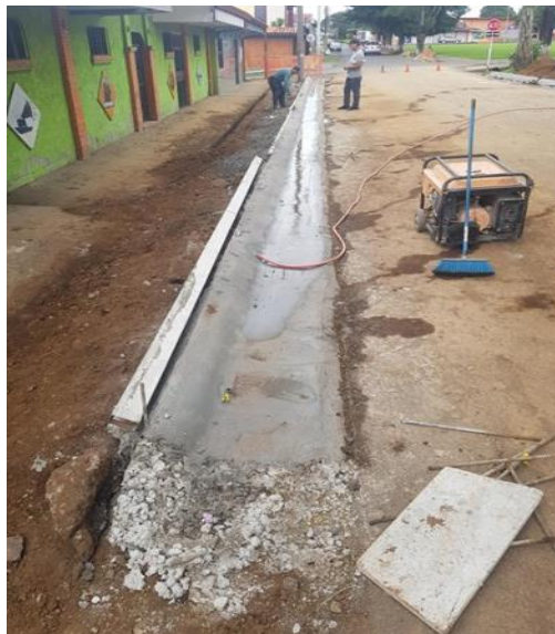
“Imagen 18 – Construcción Cordón y Caño Proyecto San Juan Costado Sur”
