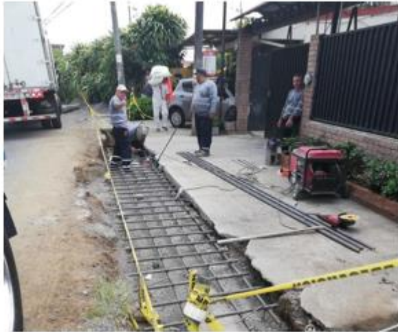
Construcción de alcantarillado y acera frente al tanque de agua Estadio Carlos Alvarado
