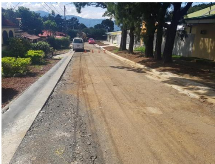
17 "Imagen #21 – Tubería, cordón y caño listo en cuadrante ESTE San Juan"
