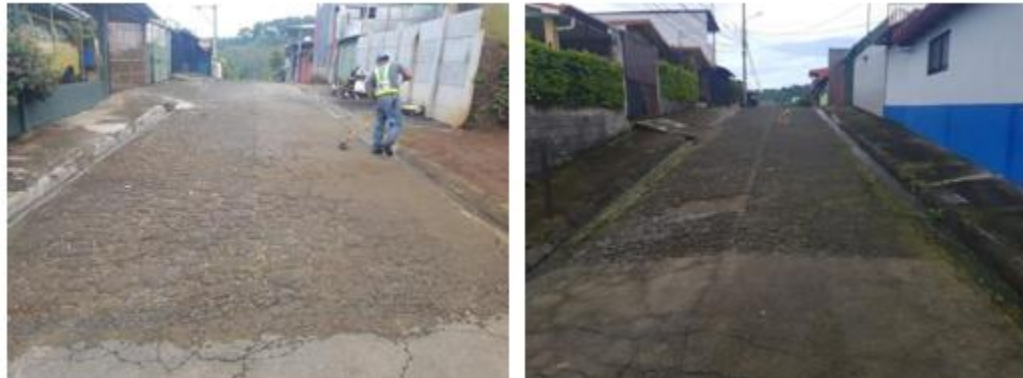
“Imagen #34 – Intervención Ramales Calle Quirós, Estado Inicial”
