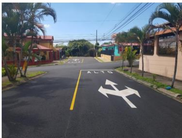
"Imagen #65 –Intervención Urbanización Cifuentes C4-04-072 (Calles Secundarias)"
