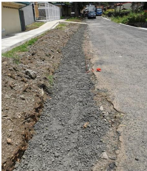
“Imagen #16 – Inicio de Intervención San Juan, camino C4-04-029”
