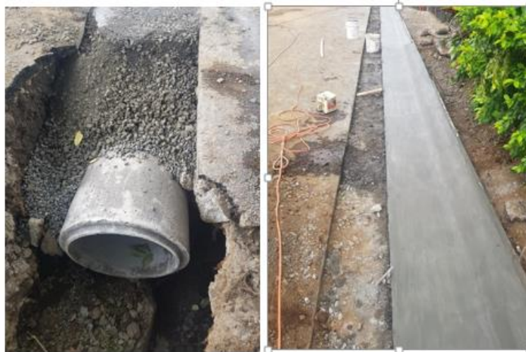
“Imagen #12 – Instalación de Tubería y Construcción de Cordón y Caño”
