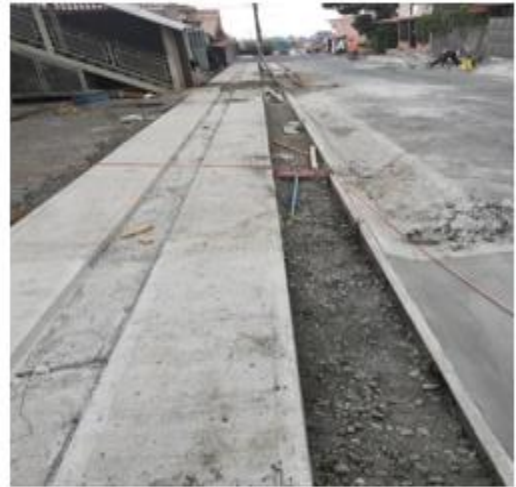
Construcción alcantarillado pluvial y cordón de caño San Juan
