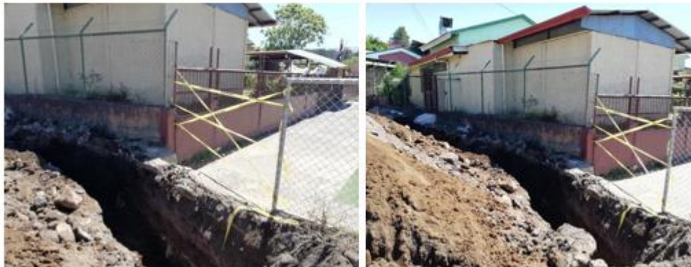
Construcción de alcantarillado costado oeste Escuela de Birri
