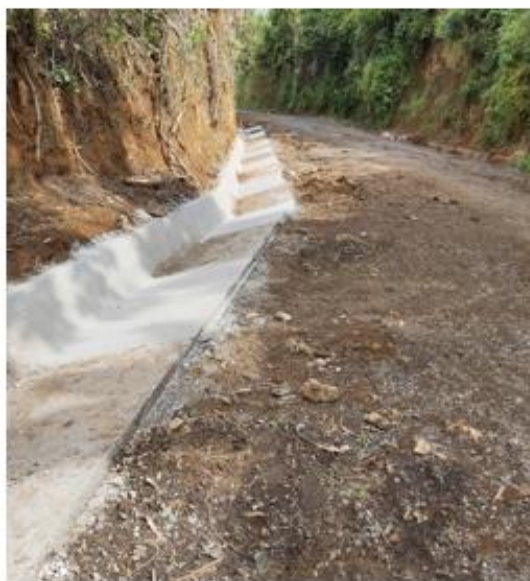
"Imagen 70 – Intervención Calle Potrerillos Construcción Cuneta, Adenda"
