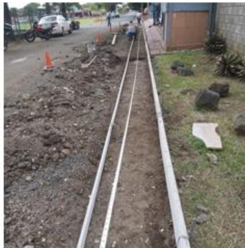
"Imagen 72 – Intervención San Juan Construcción Cordón y Caño, Adenda"
