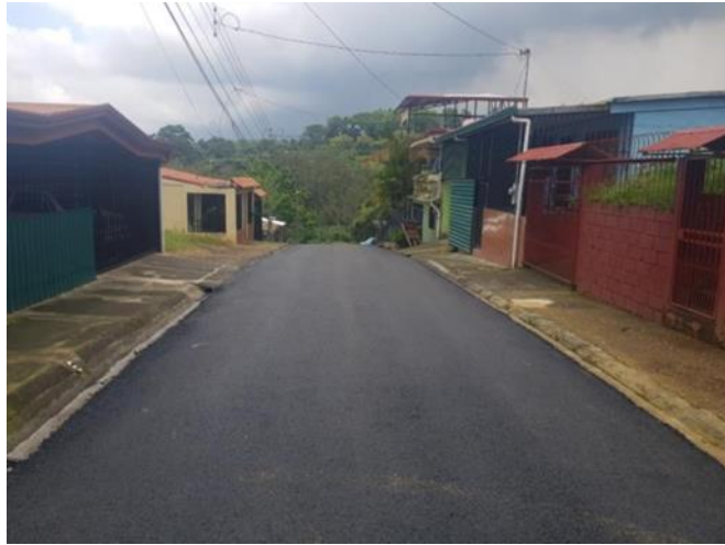
“Imagen #35 – Intervención Ramales Calle Quirós C4-04-005”
