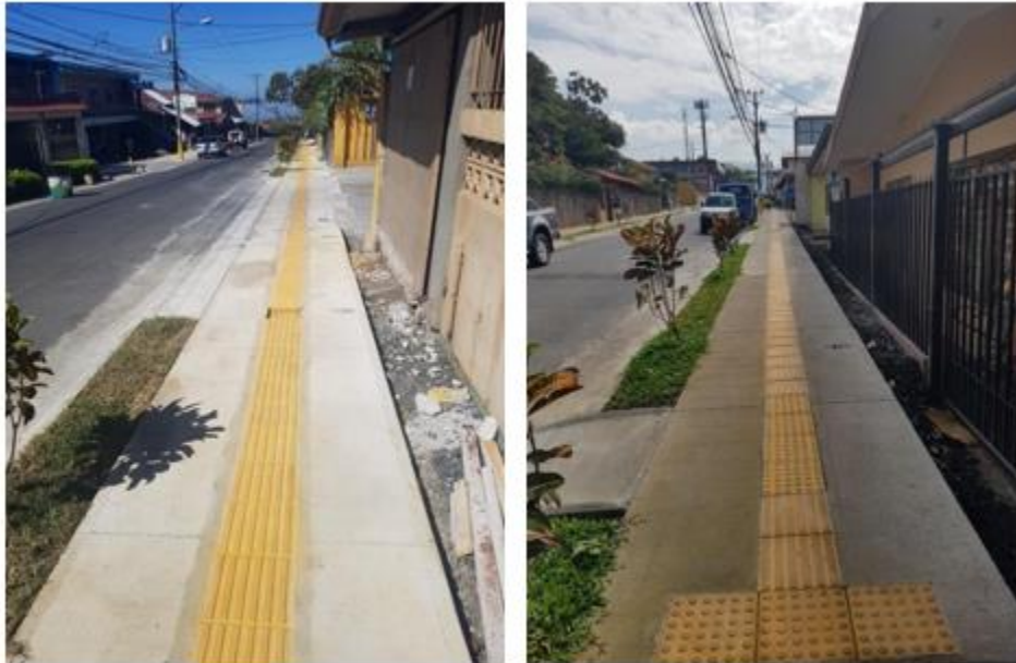
"Imagen #1 – Construcción Aceras Distrito Centro"
