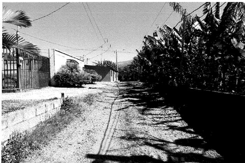
"Imagen #4 - Estado actual de Calle Guüérrez Sección Lastre"
