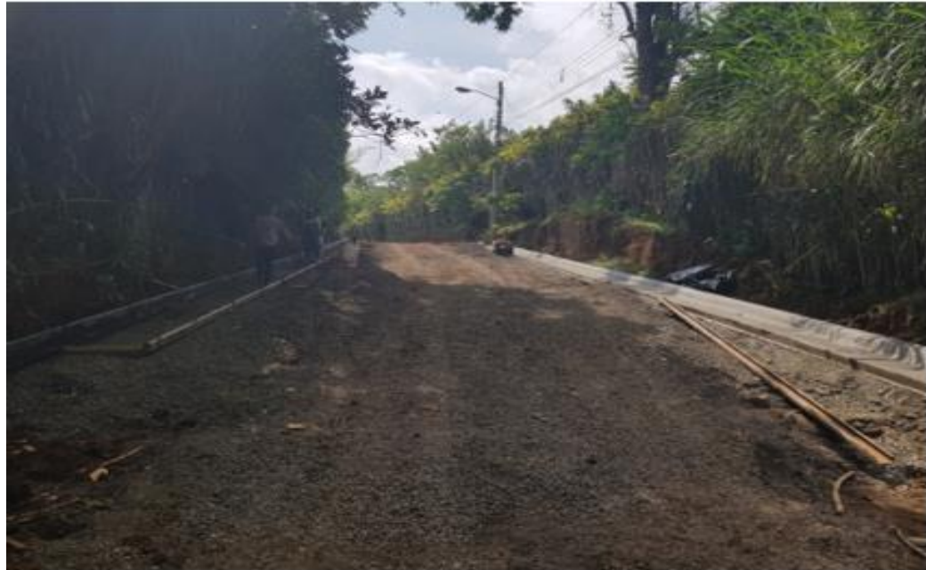
“Imagen #22 – Avance de Obras Calle Rosales-Betania”
