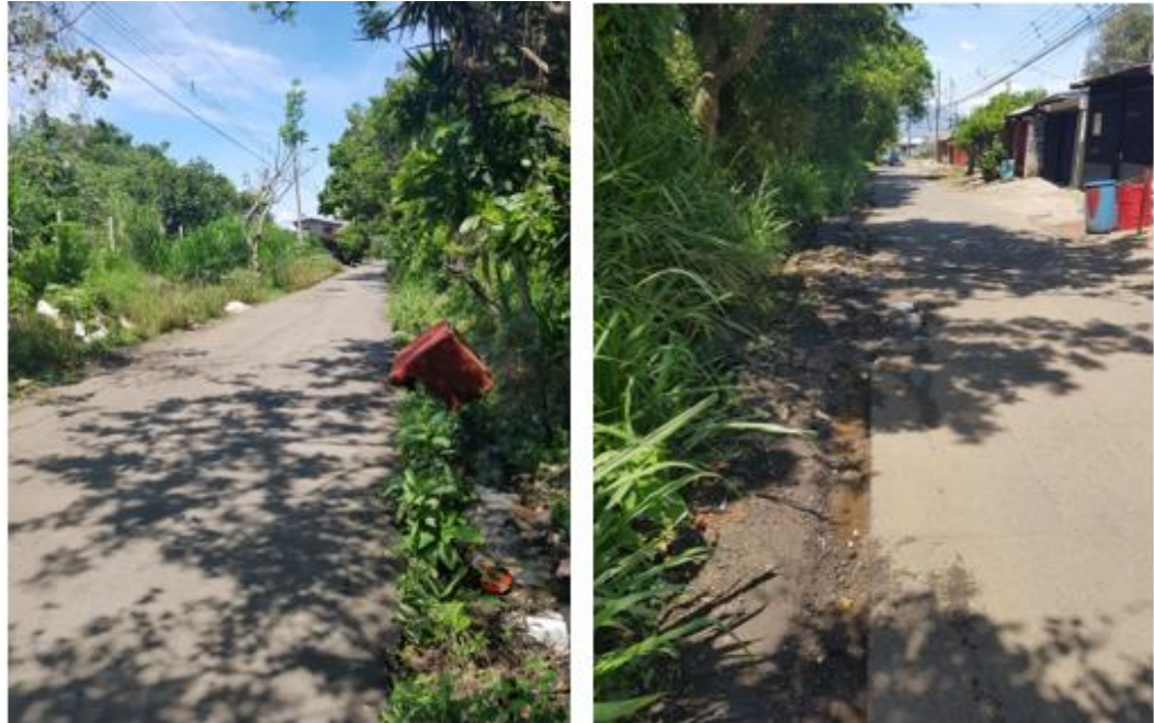
“Imagen #31 – Estado inicial Calle Zapote”
