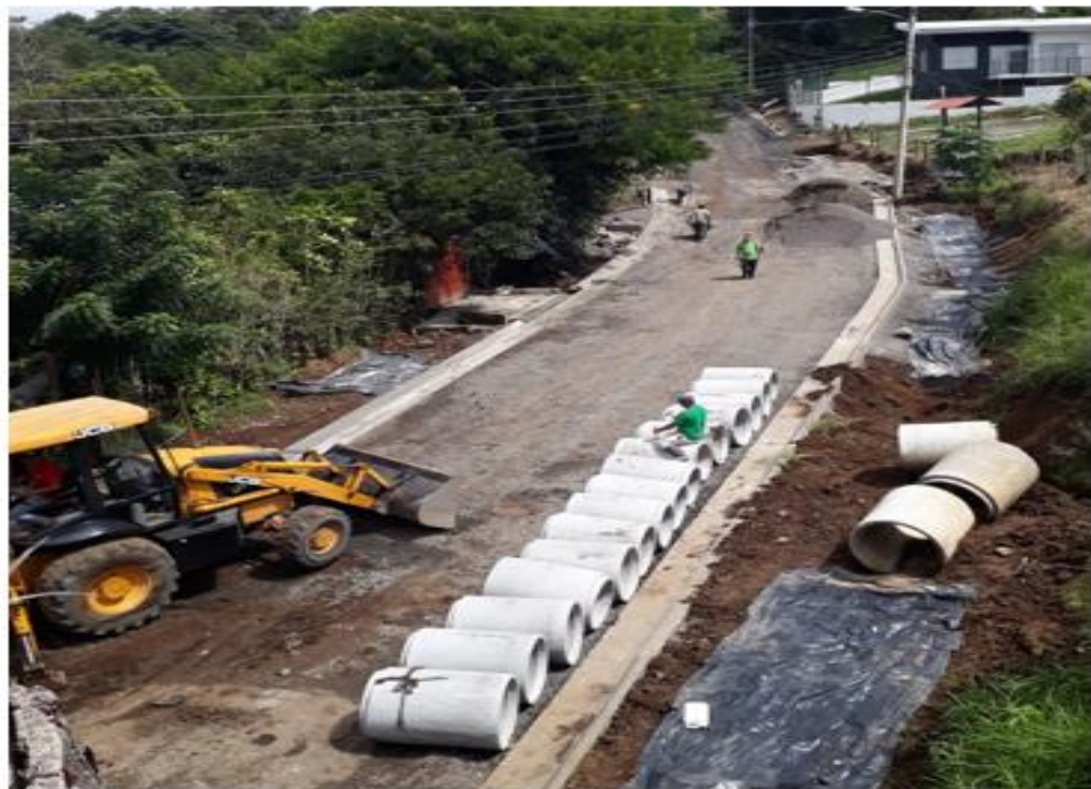
“Imagen #23 – Avance de Obras Calle Rosales-Betania”
