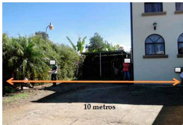
Fotografía nro. 11 Construcción en área de protección
