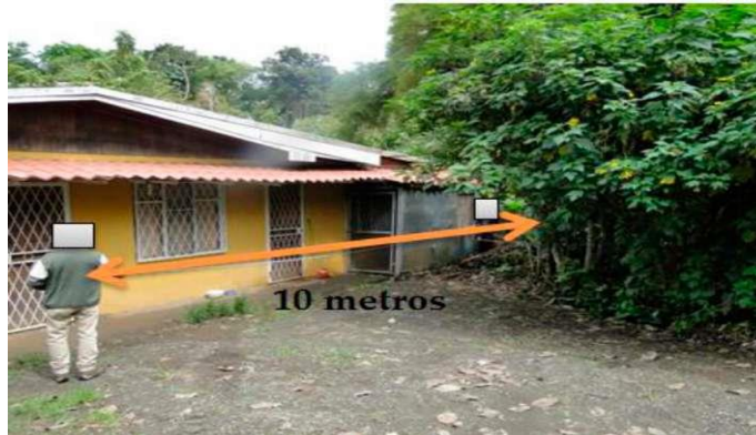
Fotografía nro. 12 Construcción dentro de zona de protección
